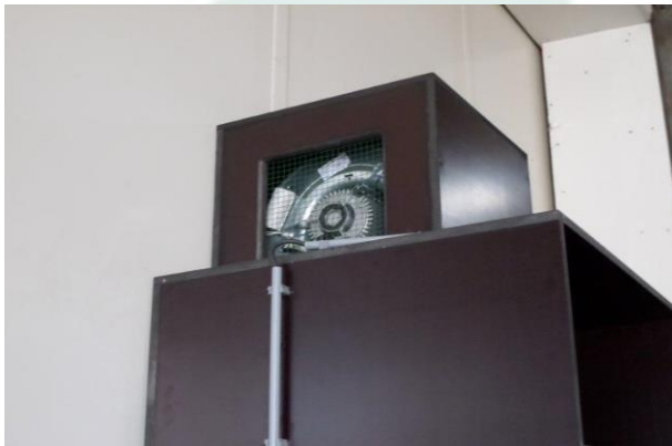
Ventilatore centrifugo per estrarre l'aria condizionata da insufflare nei semi.
