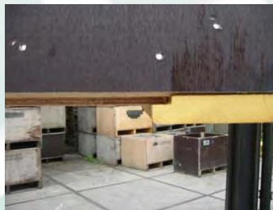
Lo spessore del multiplex è diverso da quello delle assi in legno.
