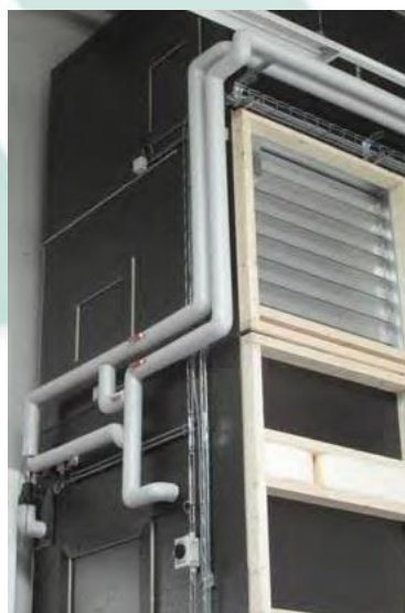
Collegamento dei tubi al radiatore del sistema di distribuzione dell'aria.
